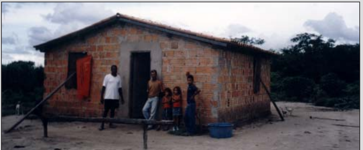
Várias casas de alvenaria foram construídas sem nenhum recurso do Estado. Serão agora covardemente destruídas como aconteceu em Goiânia?!
